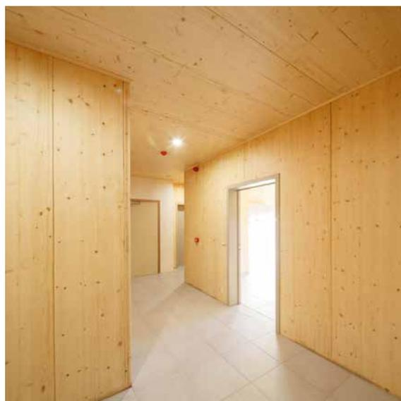
Figure 1 : Chemin d'évacuation en bois massif ignifugé. Résidence Service le Fontiloy, Belgrade. ©Stabilame
