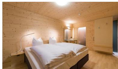
Cet hôtel est réalisé selon une combinaison de bois (100 % épicea massif) et d'argile. Ses composants préfabriqués ont été assemblés à l'aide de chevilles en bois, sans aucune colle. Un mélange isolant liège-argile protège ses façades mitoyennes. Le bâtiment se compose d'une quinzaine de chambres et d'une salle de restaurant.
